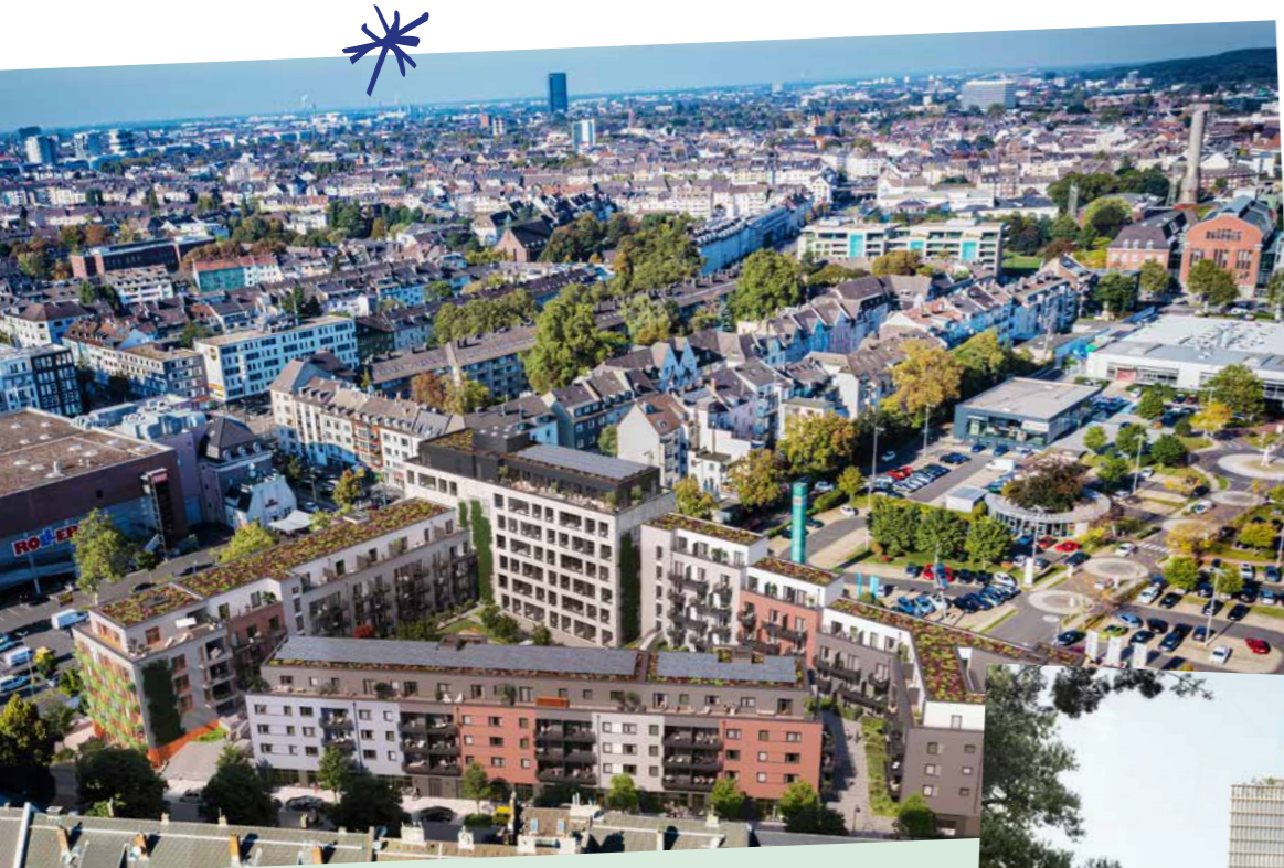
Abb. 18: Cube Central 378 (im Bau)
